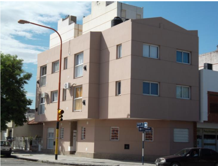
Vivienda Multifamiliar. Calle Sta.Fé esquina Donado, Bahía Blanca. Proyecto: Ing. De Carolis E. Luis con Arq. De Carolis María Martha.
